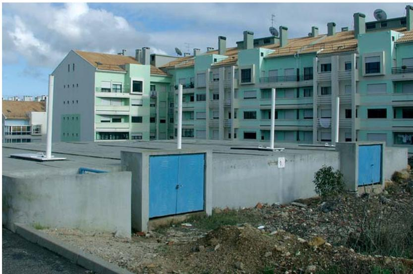
Fig. 12 Reservatório enterrado para GPL.
